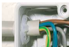
Фиксация кабеля с помощью фиксаторов KHR
