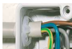
Фиксация кабеля с помощью фиксаторов KHR
