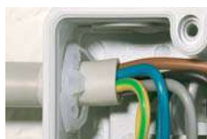
Фиксация кабеля с помощью фиксаторов KHR
