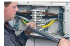
Клеммы должны быть затянуты с определенным усилием
