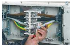
Проводники должны быть тщательно зачищены от окислов
