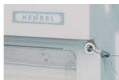
Пломбирование верхней и нижней части боксов KV
