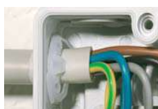
Фиксация кабеля с помощью фиксаторов KHR
