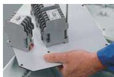
Монтаж устройств на монтажную плату
