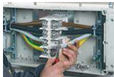
Проводники должны быть тщательно зачищены от окислов
