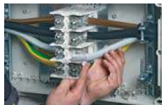
Проводники должны быть покрыты специальной смазкой, без содержания кислот и спиртов, и немедленно подключены
