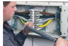
Клеммы должны быть затянуты с определенным усилием
