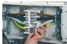
Проводники должны быть тщательно зачищены от окислов
