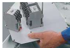
Монтаж устройств на монтажную плату
