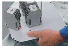
Монтаж устройств на монтажную плату
