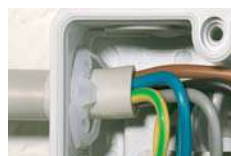
Фиксация кабеля с помощью фиксаторов KHR
