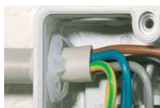
Фиксация кабеля с помощью фиксаторов KHR
